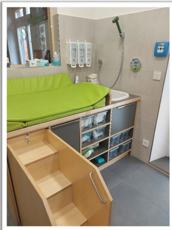
Abbildung 20: Wickelbereich mit Treppe und Sitzdusche
